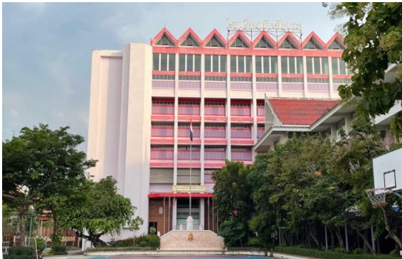
อาคาร 1 อาคารปฐมเทพมุนีศรีราชรัตนภรณ์
