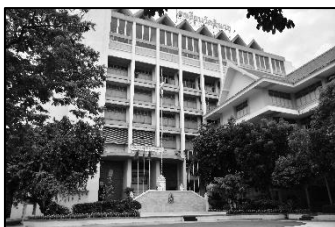
อาคาร 1 อาคารปฐมนิเทศน์พระรัตนตรัย เป็นอาคาร 8 ชั้น และห้องปฏิบัติการห้องประชุม
